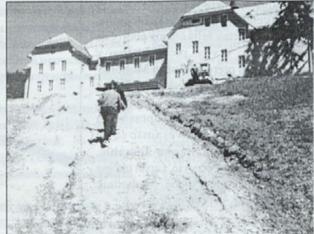
Gradbena dela bo izvajalo gradbeno podjetje Korpar d.o.o. iz Ptuja.
