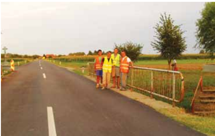
Ograja še pred začetkom obnove
