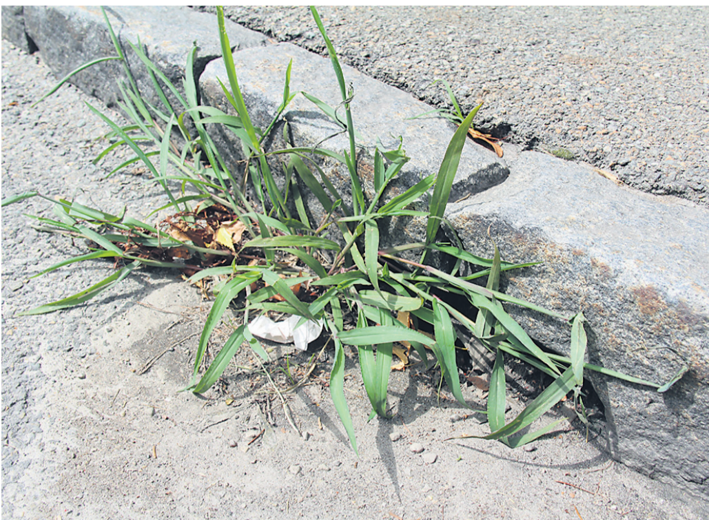
Še ena cvetka: s travo zaraščen in zamuljen odtok
