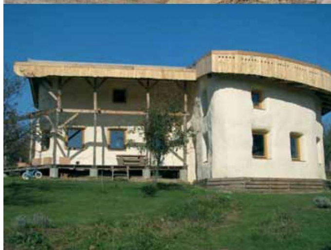
Slika 7: Tudi v Sloveniji je že nekaj objektov grajenih s slamnatimi balami. V obeh predstavljenih primerih gre za sistem lesene skeletne konstrukcije s polnilom slamnatih bal. Levo hiša na Kureščku [vir: http://www.soustvarjanje.si], desno hiša v Čikečki vasi [foto: Kristijan Zver].
