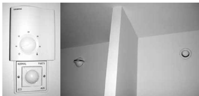
Slika 2: Napravi za upravljanje PSH in vhodni in izhodni zračni ventil PSH. Figure 2: PH operating instruments and PH air outlet/inlet valves.
