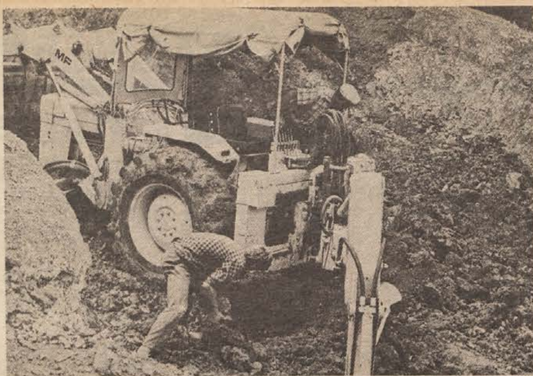
Splošna vodna skupnost Dolenjske dela v Kandiji na Partizanski cesti črpališče in zadrževalni bazen deževnih vod. Na sliki: delavca vodne skupnosti pri delu. (Foto: J. Pezelj)
