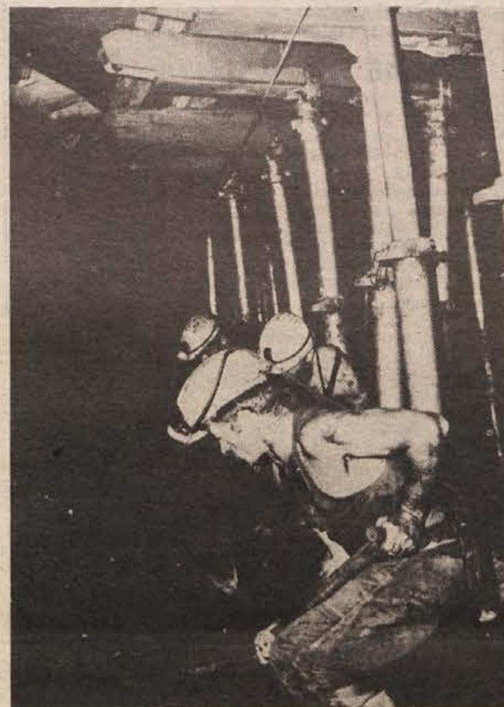
Rudarji v Kanižarici so se spet modernizirali. Na odkopnem čelu uporabljajo najmodernejše hidravlične stropne nosilce in hidravlične podpornike. (Foto: M. Vesel)
