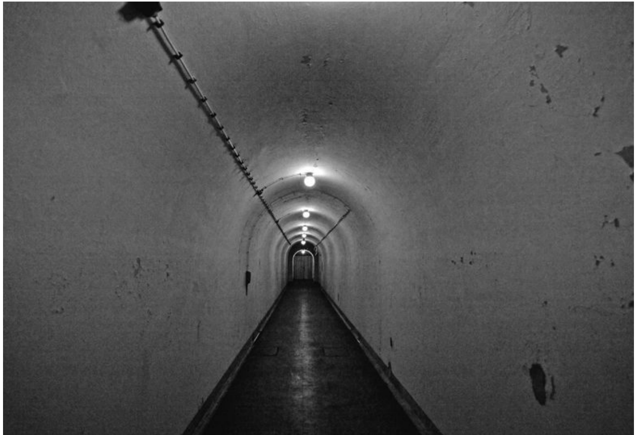
Objekt visoke zaščite, namenjen republiškem vodstvu, so v Gotenici začeli graditi leta 1950.
