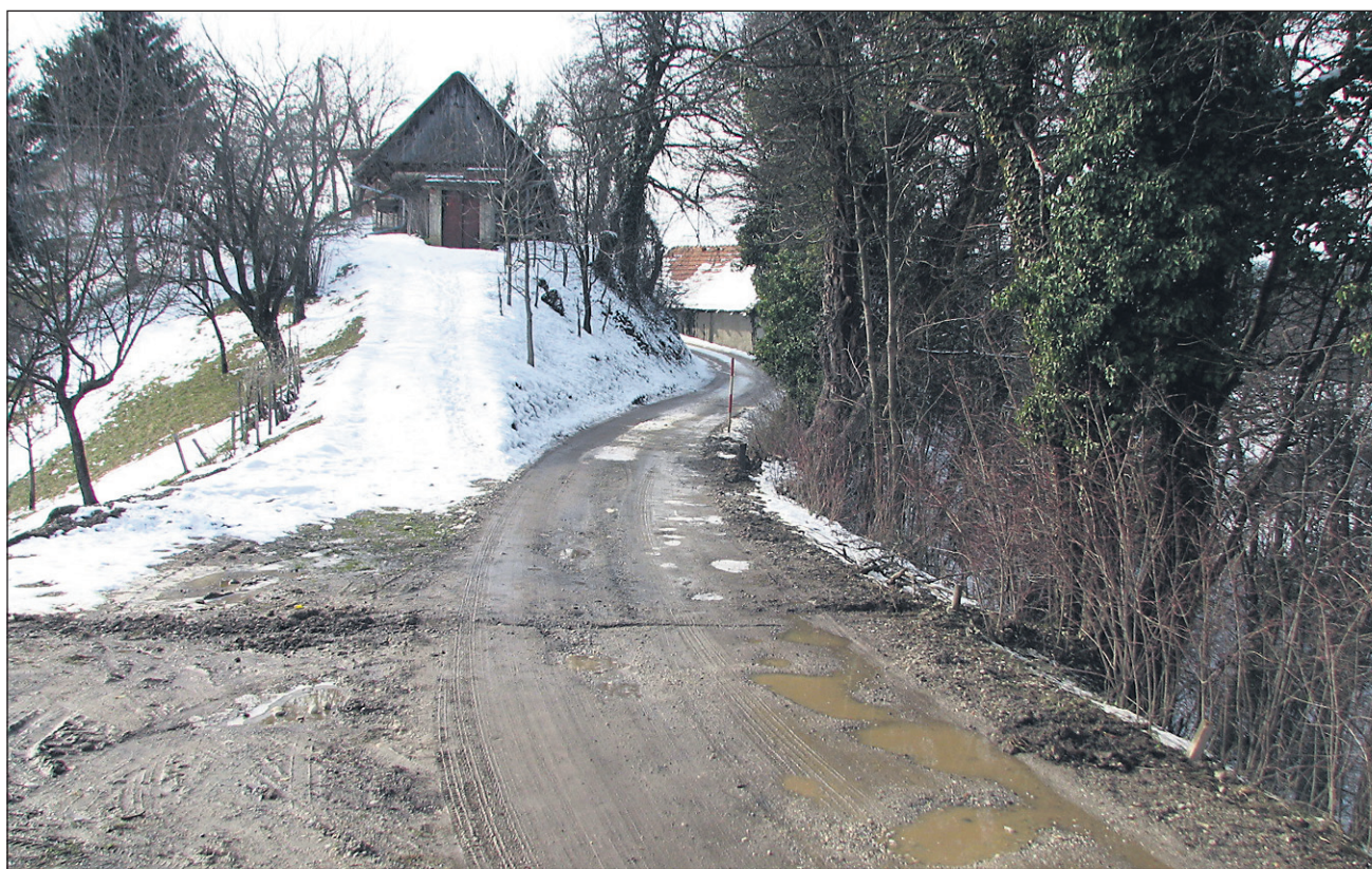
Cesta v Trdobjcih od hišne št. 25 naprej je neasfaltirana, zaradi slabega gramoziranja pa tudi vedno bolj luknjasta in pozimi neprevozna, saj po makadamu ne plužijo.
