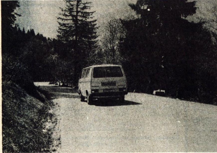
Že nekaj časa je na cesti proti mejnemu prehodu Podkoren promet oviran, saj se je udrla cesta. Zato je prepovedan promet z avtobusi, pričakovati pa je, da bodo v turistični sezoni na cesti precejšnji zastoji. — Foto: D. Sedej
