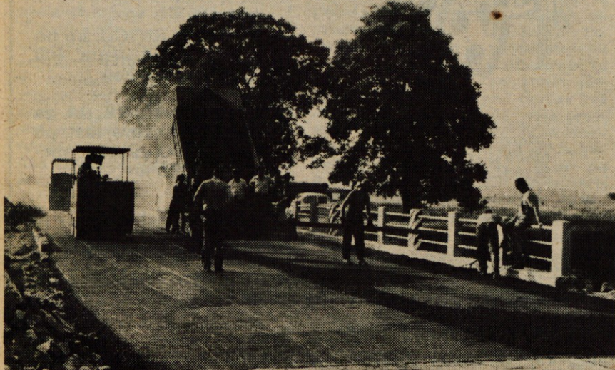
V začetku tedna je Cestno podjetje iz Kranja obnovilo tri mostove na cesti Kranj—Jesenice v radovljiški občini. Granitne kocke so zamenjali z asfaltom na mostu, kjer je odcep za Begunje in za Radovljico, na odcepu za Lesce in na mostu pred križiščem za Bled. — Foto: F. Perdan
