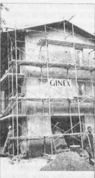
Sanirana stavba v Drežniških Ravnah
