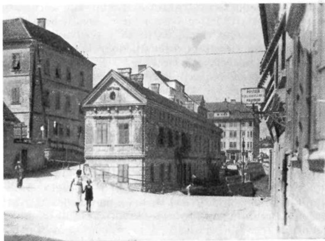
Nekdanje križišče Tržaške in Pobreške ceste ter Taborske ulice
