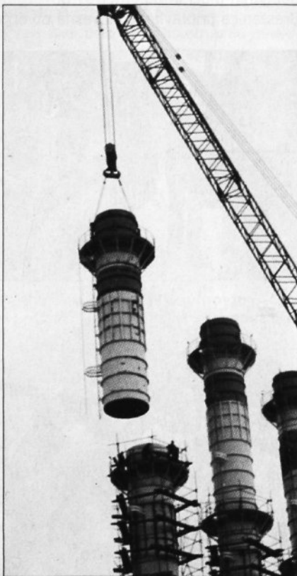
Vzdrževanje dimnikov PPE
