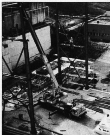
Začetek montaže konstrukcije glavnega pogonskega objekta
