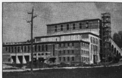
Termoelektrarna na premogovno kurjavo »Rajhenburg« v izgradnji
