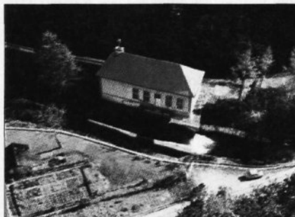
Črpališče na potoku za oskrbo s tehnološko vodo (modernizirano).
