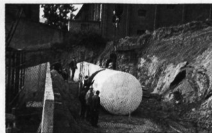
Dnevni rezervoarji so bili predvideni za kurjavo plinskih turbin z ekstra lahkim kurilnim oljem in primarnim bencinom.
