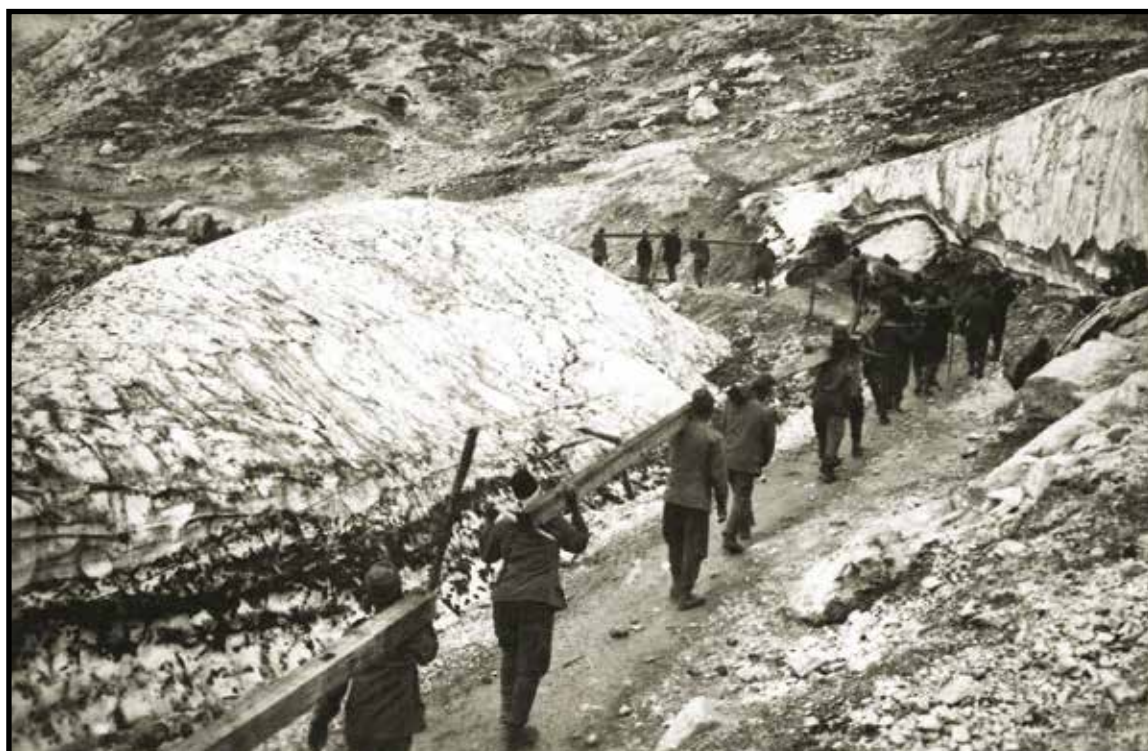
Za gradnjo vojaških objektov v Krnskem pogorju je bilo po strmih poteh potrebno prenesti veliko gradbenega materiala: prenašanje tramov med Komno in Krnskimi jezeri. (Muzej novejšje zgodovine Slovenije)
