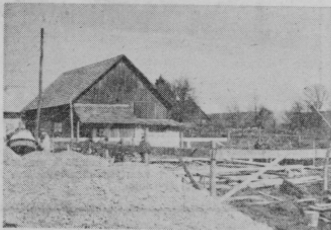
Gradnja temeljev za novo Dravsko polje Lovrenc
