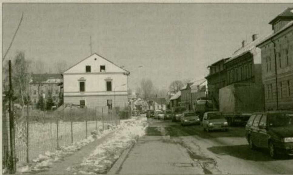
Na Mariborski bosta najprej padli dve hiši, zatem bodo v traso zaorali buldožerji in pričelo se bo prestavljanje številnih komunalnih vodov.
