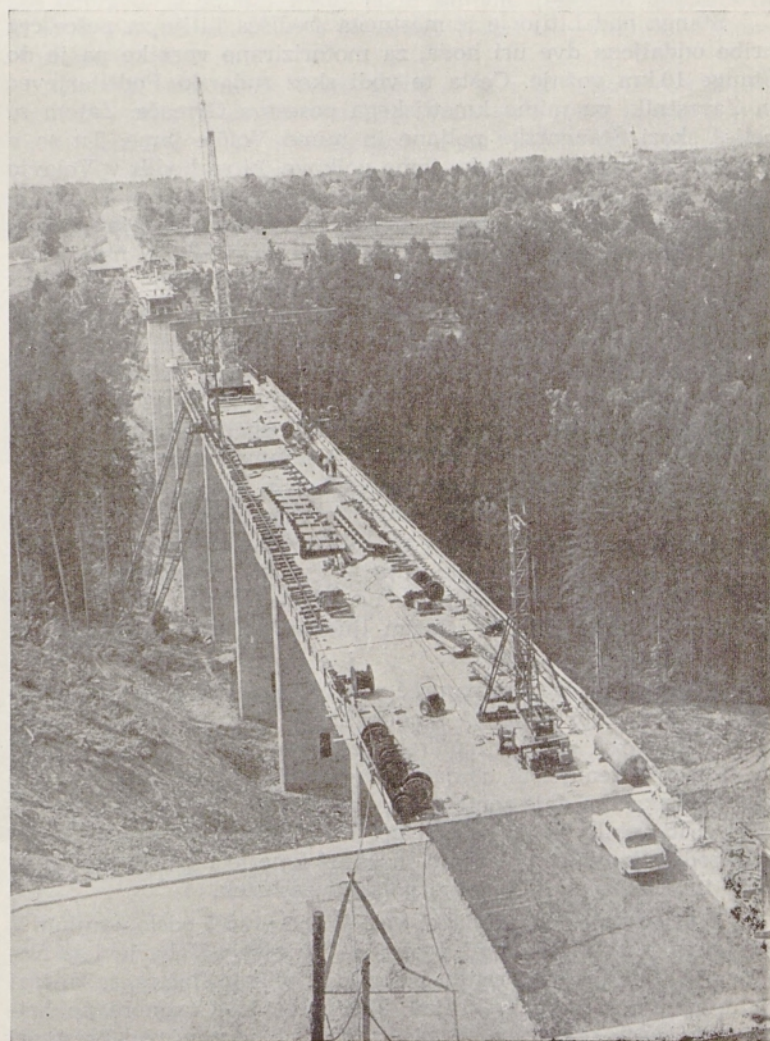
2 Most čez Peračico med gradnjo
