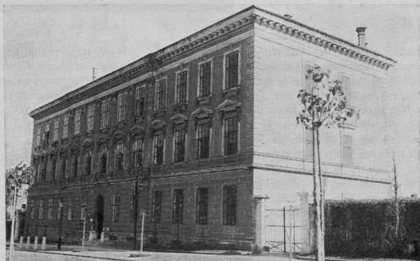
II. deška osnovna šola — Graben — zgrajena 1875
