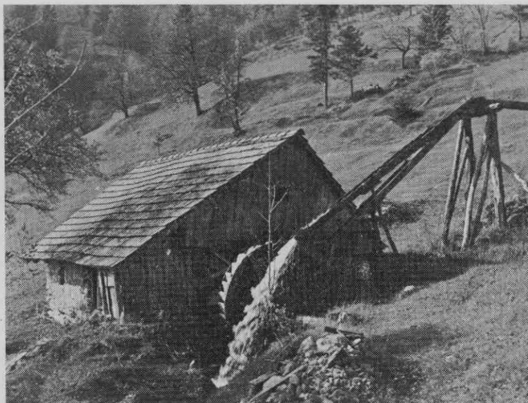
Zarobarjev kmečki mlin pri vasi Suša v Poljanski dolini s kolesom na zgornjo vodo (foto Janez Eržen)
