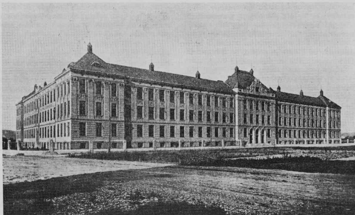
Poslopje tehniške srednje šole v Ljubljani (zgrajeno 1911. leta)
