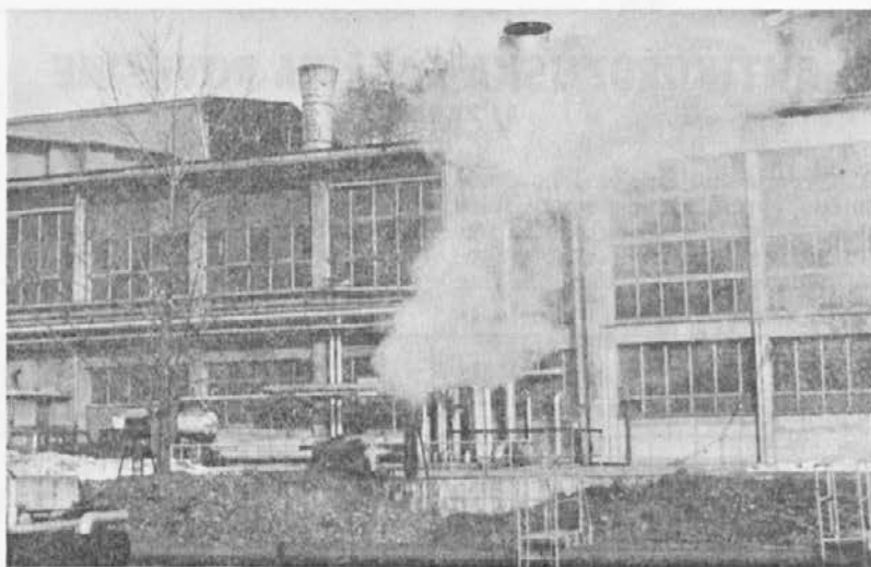
Kotlarne — vir toplote
