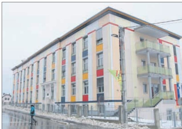
V Lambrechtovem domu z novogradnjo niso zadovoljni. V ponedeljek naj bi eno od dvigal pristalo v vodo.
