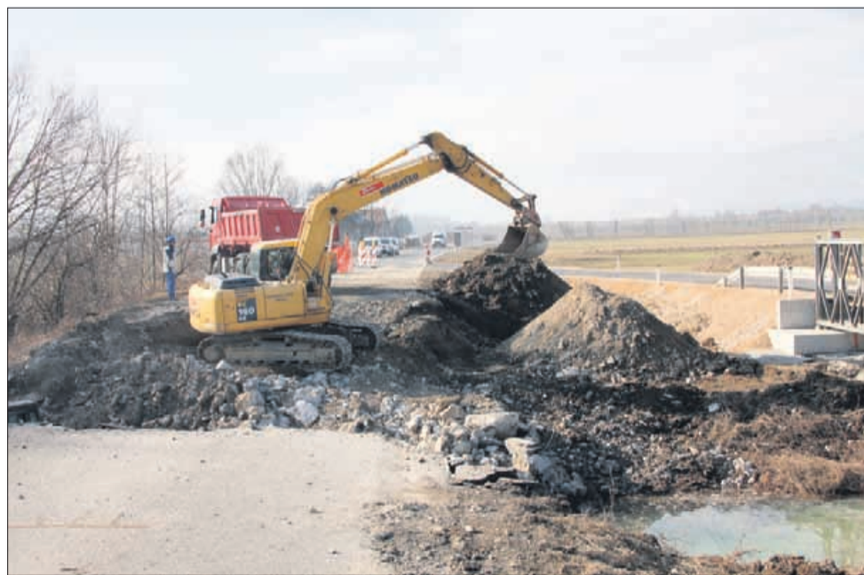
Začetek gradnje novega mostu
