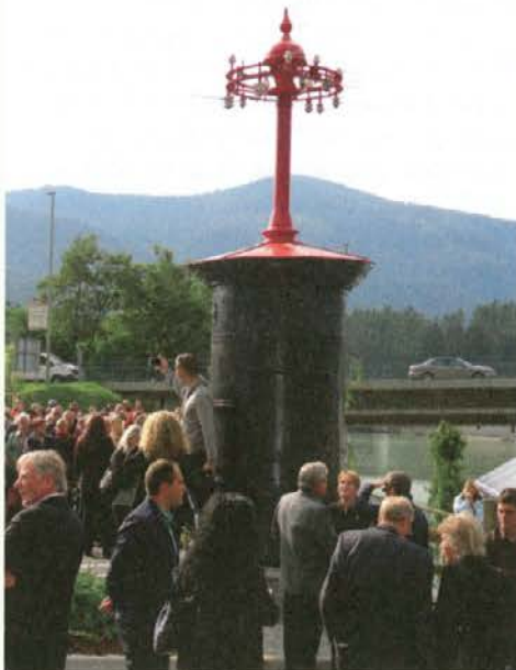
Transformator iz leta 1908
