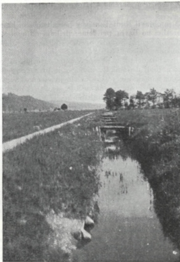
Slika 17. Dobro vzdrževani kanal na Barju
