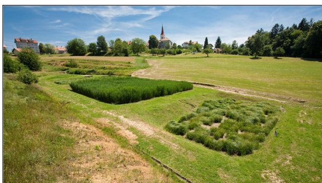
Slika 22: Rastlinska čistilna naprava v Svetem Tomažu, Vir: arhiv Limnos.
