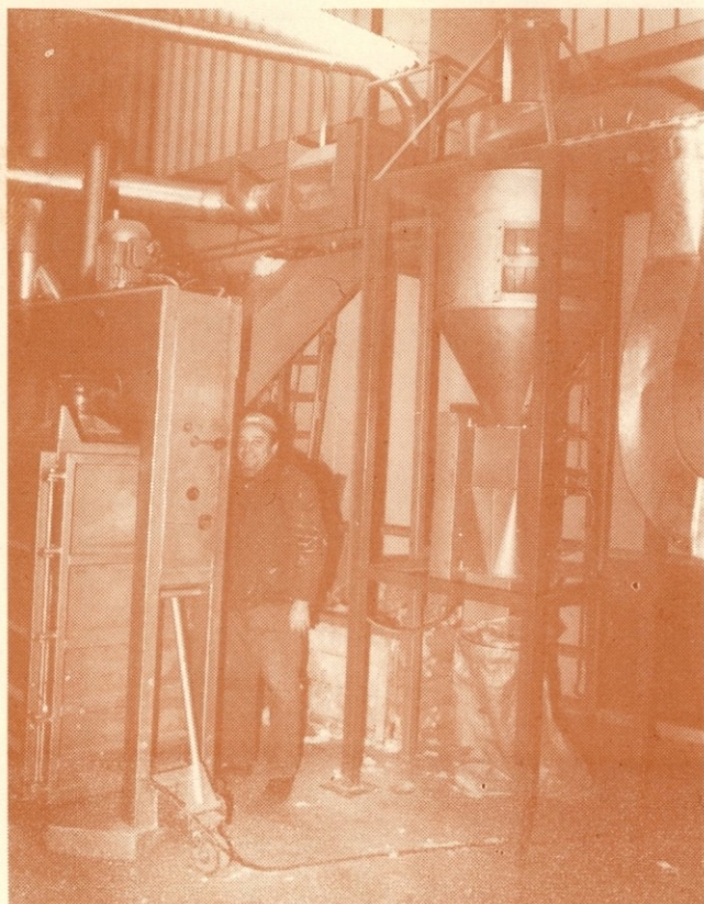
Del naprav proizvodne linije za čiščenje bombažnih vlaken-skih odpadkov
