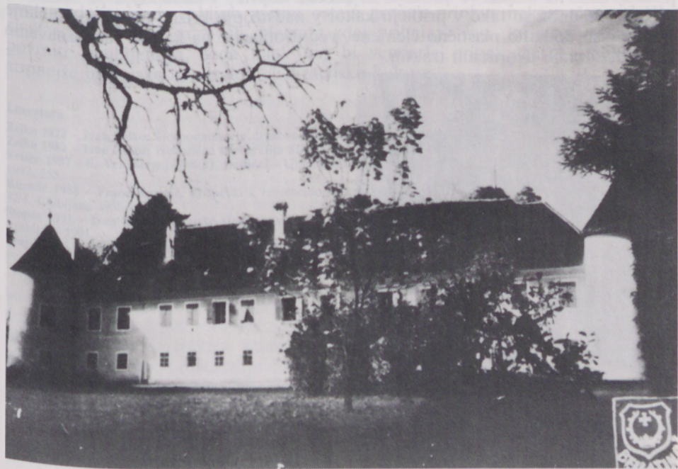
Vzhodno pročelje belt. dvorca – po razglednici po 1. vojni
