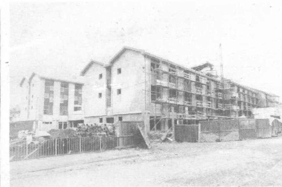
Zadnja gradbena dela na Domu za ostarele občane v Kozelji
