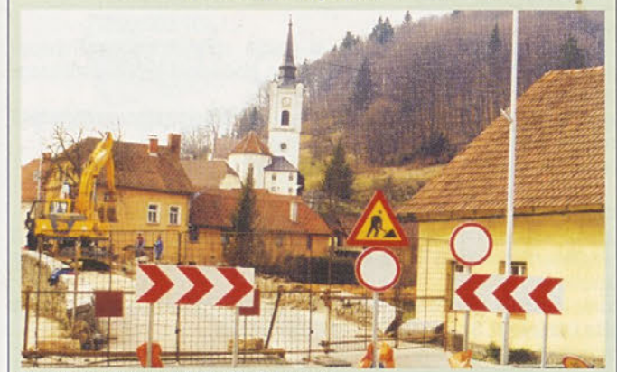
Stop! Popravilo mostu! /foto D. Zakrajšek/
