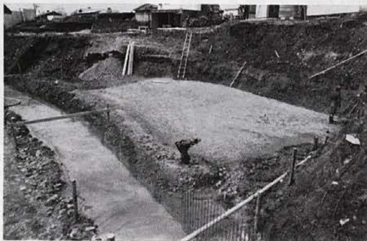
Priprava za gradnjo objekta hladilne vode
