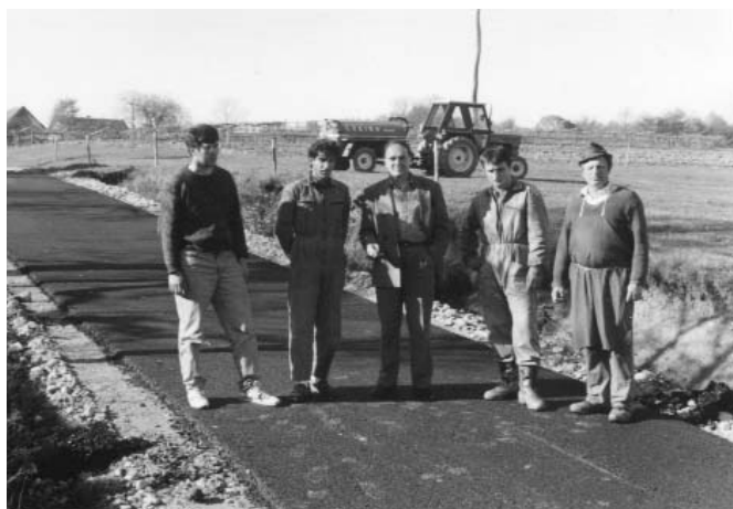
Makadamsko cesto je zamenjal asfalt.
