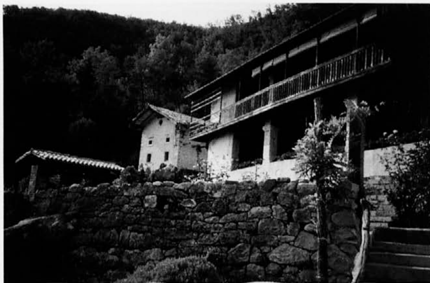
Prehod št. 1, obnovljena domačija »Šebau«, pogled s spodnjega dvorišča na gospodarsko in stanovanjsko poslopje, 1998 (foto: M. Ravnik)
