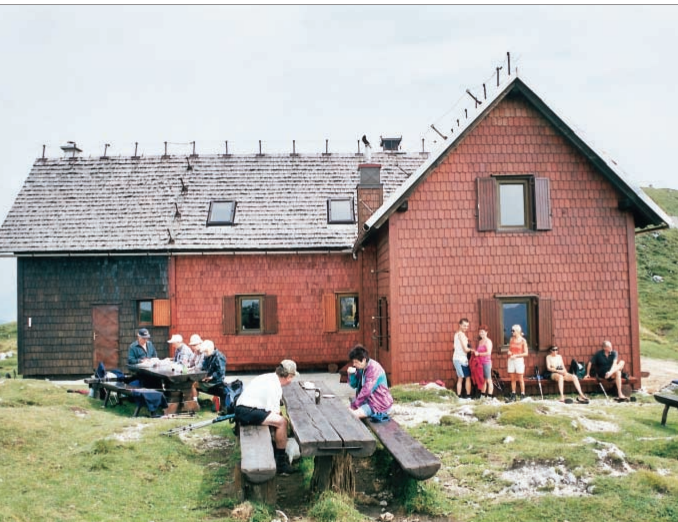
Pred Krekovo kočo na vrhu Ratitovca z nadmorsko višino 1642 metrov se zemeljski električni kabel sklene s priključno omarico.
