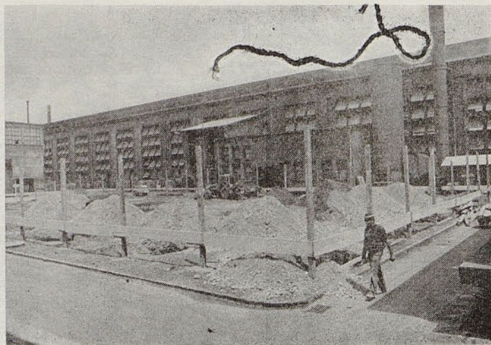
Izgradnja poslopja za predelavo žilindre
