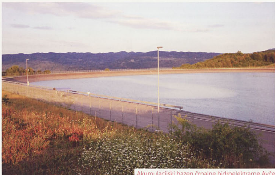
Akumulacijski bazen črpalne hidroelektrarne Avče
