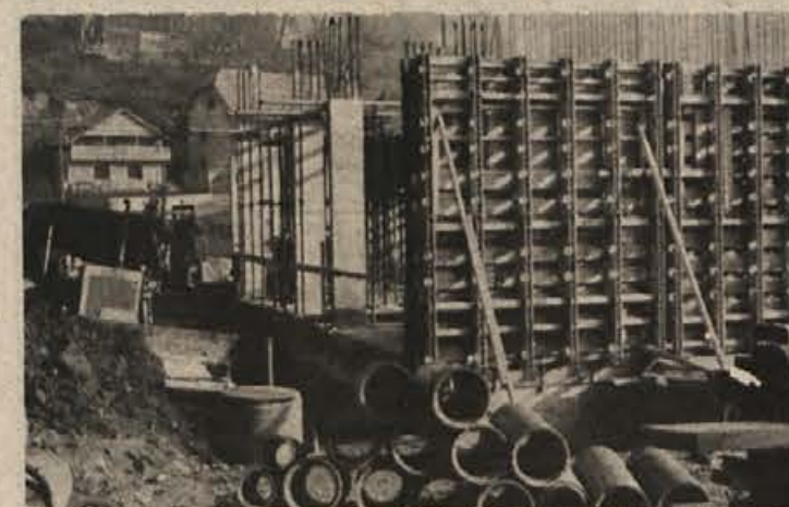
V Sodražici kar hitro raste nova poslovno-stanovanjska stavba. Razmeroma lepo vreme ugodno vpliva na gradnjo. (Foto: Primc)
