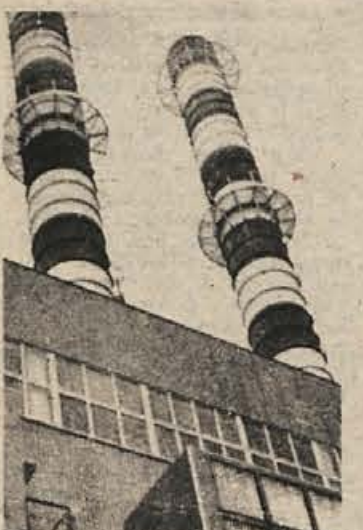
26. novembra je prispel iz ZRN obnovljen tretji generator nove plinsko-parne elektrarne v Brestanici. Montažna skupina hiti, da bo celotna elektrarna nared še pred novim letom.
