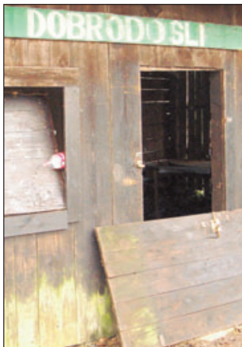
Zapuščeni objekti so raj za uživalce nelegalnih drog. (Na fotografiji »zandalizirana« koliba v Mavčevi dolini)
