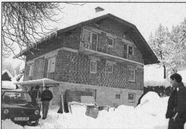
Nova hiša Škrubejevih je zrastle na mestu stare hiše (foto:ToP)
