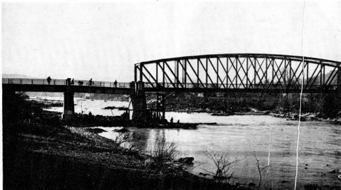
Most čez Savo pri Tacnu, ki ga je zgradil kr. dež. odbor l. 1909/10.
