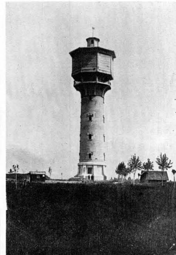
34 m visok stolpni rezervoar vodovoda
