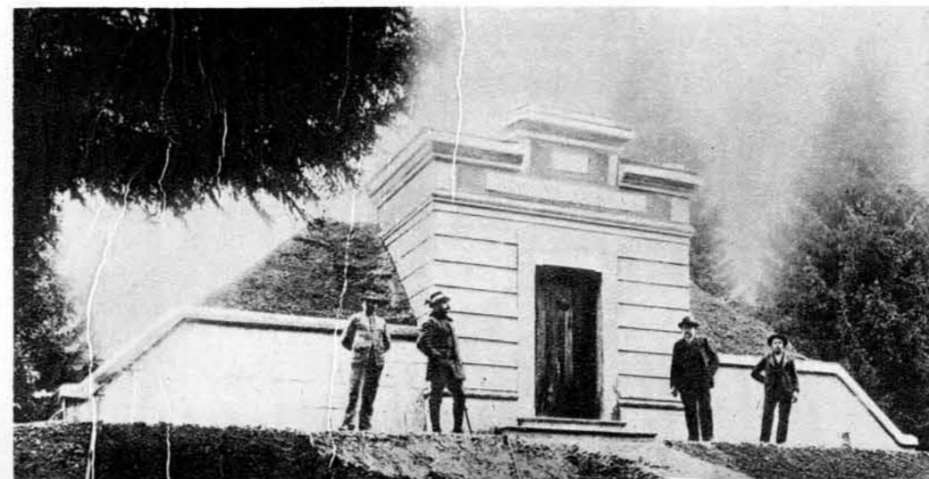
Vodni nabiralnik vodovoda za Radovljico in okolico
