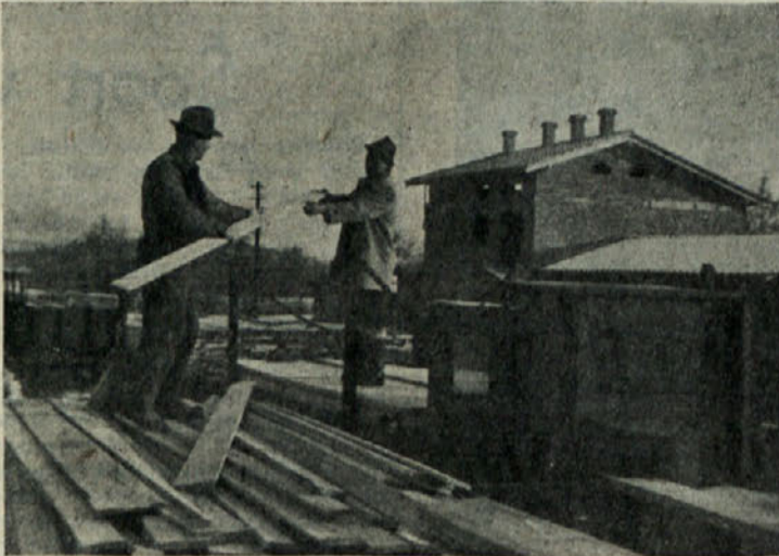
Postaja bo kmalu zgrajena
