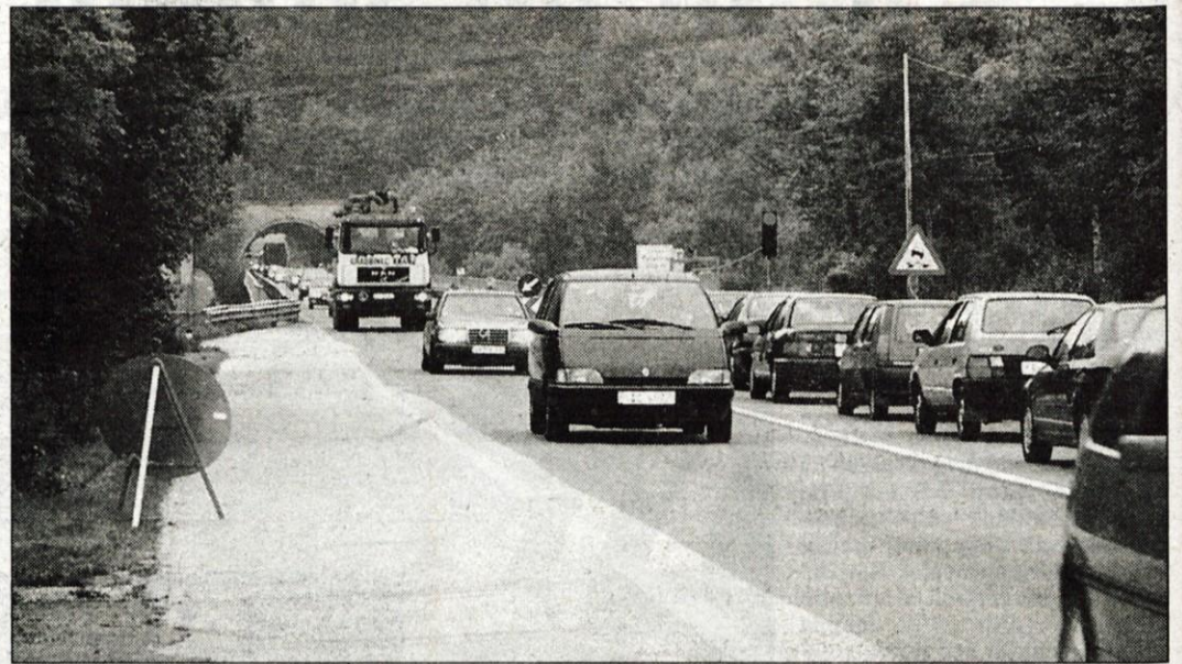
Obnova viadukta Peračica povzroča precejšnje prometne zastoje. Foto: M. Va.
