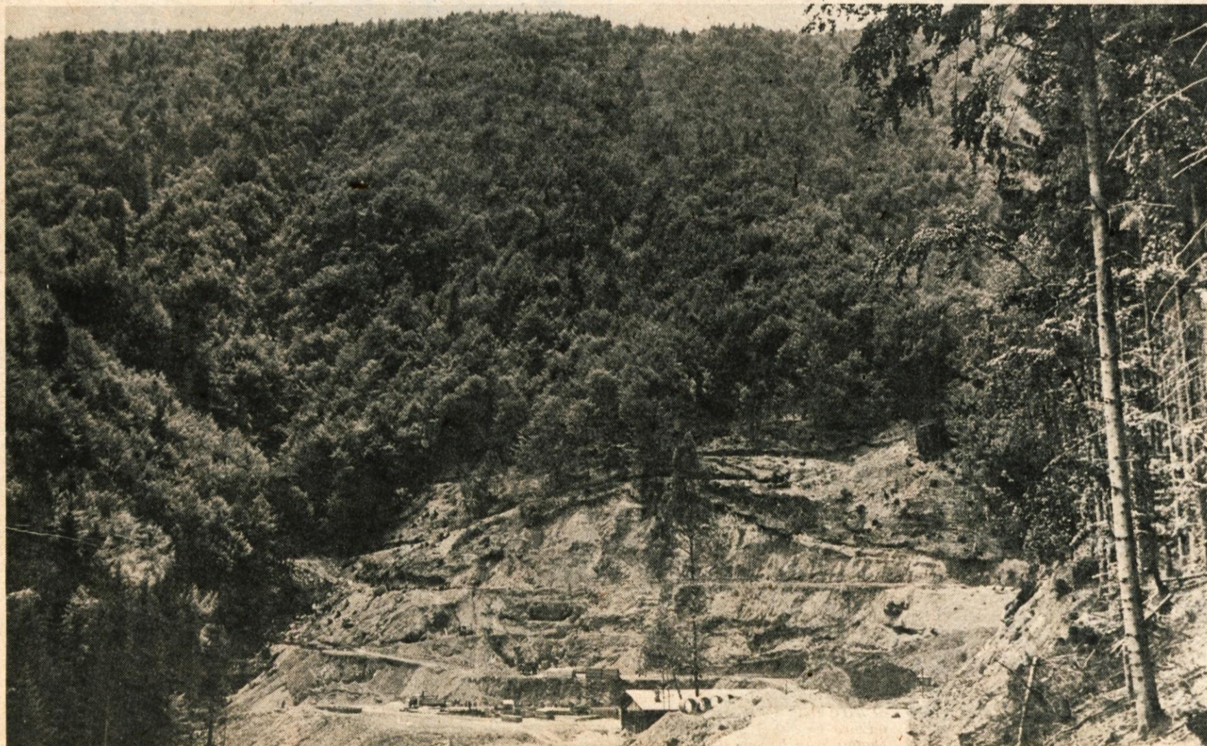
Delovna plosčad in del nove dostopne ceste
