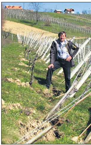
Milan Krajnc v vinogradu, ki ga bo treba po vsej verjetnosti opustiti. Betonske sohe so se premaknile za dober meter navzol.
