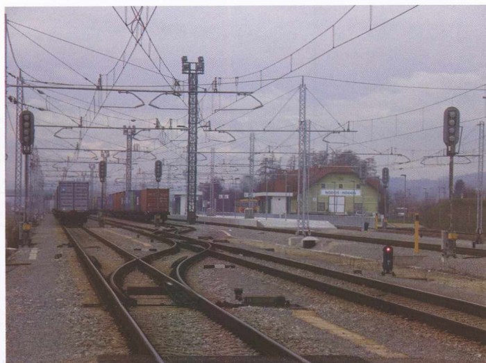
ELEKTRIFIKACIJA ŽELEZNIŠKE PROGE
