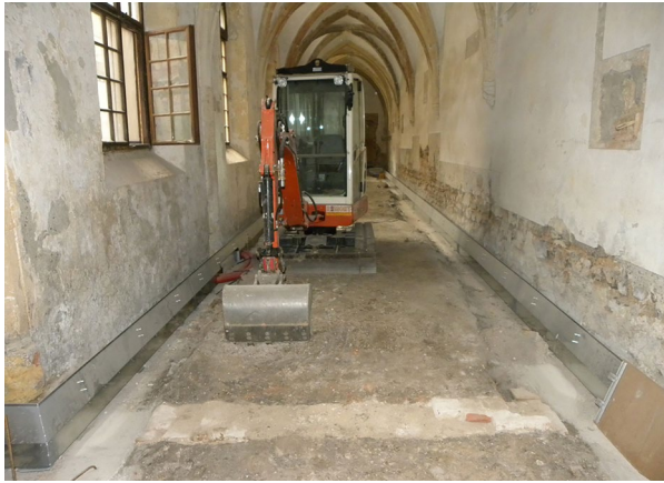
Slika 53 Strojni izkop nasutja SE 594 v vzhodnem traktu križnega hodnika (foto D. Belić).
