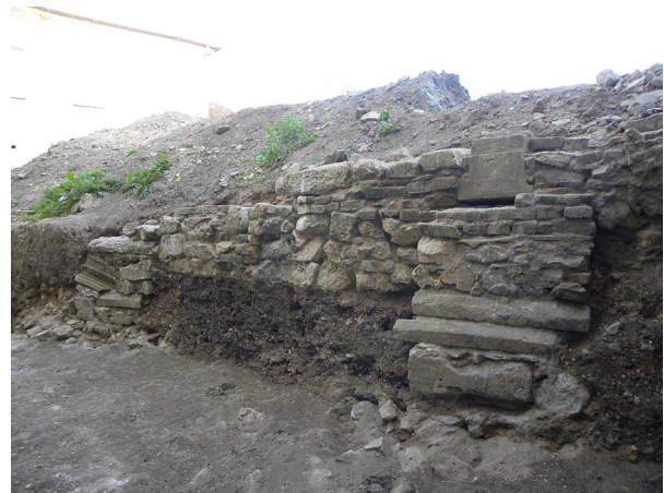
Slika 83 Pogled na novoveški temelj z vgrajenimi elementi nekdanjega gotskega prezbiterija, SE 1109, SE 1110, SE 1111 (foto D. Belič).
