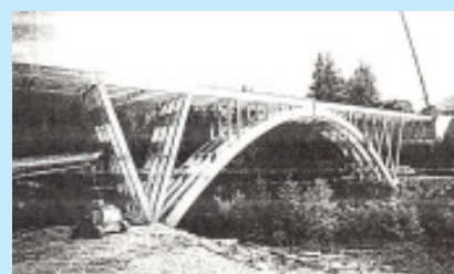
□ Slika 15. Holz-Europabrücke čez Muro v Avstriji med gradnjo (1992) /5/
