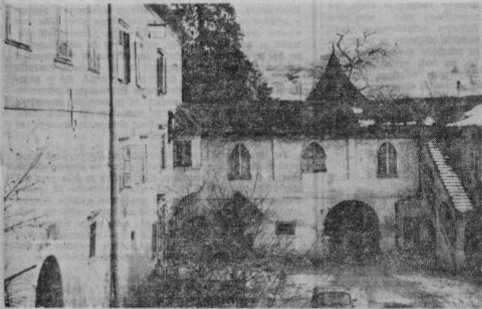
Pogled na staro graščino v Socki, ki kljub razmazanim zidovom še vedno služi tudi kot šola.
