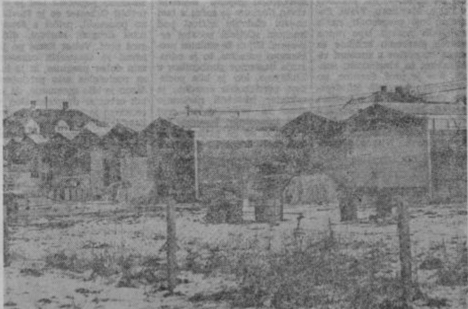
VRTEC NA POLZELI POD STREHO — V centru Polzela, kjer gradi gradbeno podjetje Gradnja iz Zalca novo vzgojno varstveno ustanovo, potekajo zadovoljivo. V vrtcu bo prostora za 140 otrok. S tem bo za nekaj prihodnjih let problem otroškega varstva na Polzeli rešen. Foto: T. TAVCAR
