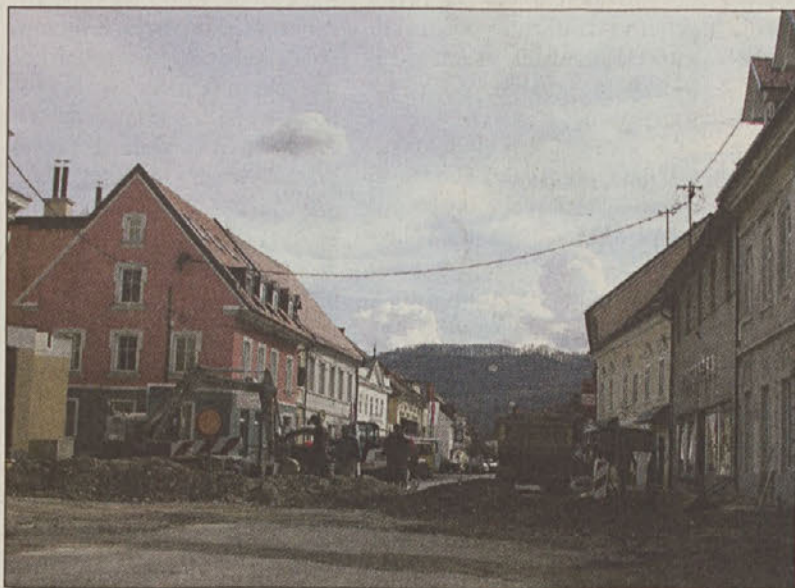
Kako dolgo bo še brežiška glavna ulica gradbišče?
