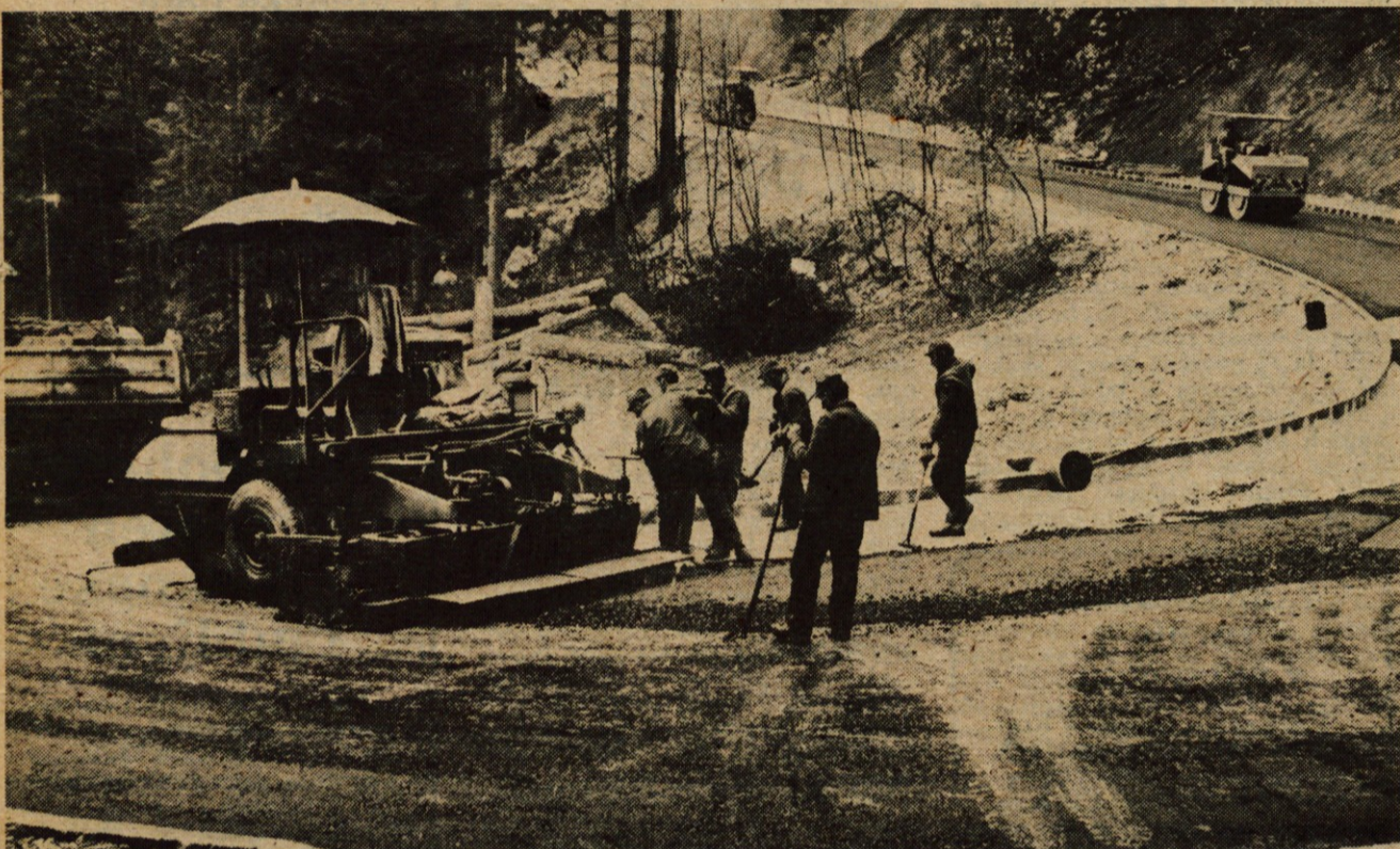
NA GOLICO PO ASFALTIRANI CESTI — Če ne bo slabšega vremena ali drugih nevarnosti, bodo delavci Cestnega podjetja iz Kranja danes ali jutri vgradili asfalt na 600 metrov dolgem odseku ceste v Jeseniški Rovt oziroma na Planino pod Golico. Tako bo asfaltiran najbolj strm in nevaren odsek poti v ta prijeten konec jeseniške občine. Zemeljska dela je opravilo podjetje Kovinar z Jesenic. (jk) — Foto: F. Perdan
