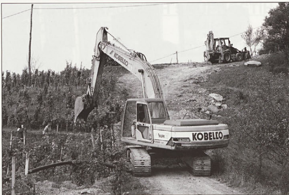
Projekt izgradnje vodovoda Zahodne Haloze, v katerega je veliko napora vložil tudi župan Bračič, se uresničuje in dela zaenkrat potekajo brez zapletov.
