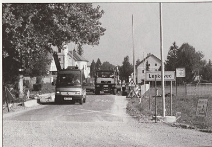
Središče KS Leskovec je bilo v prvih dneh oktobra eno samo gradbišče. Cestarji so namreč na novo izvajali pripravljala dela za pločnik ob športnem igrišču ...
