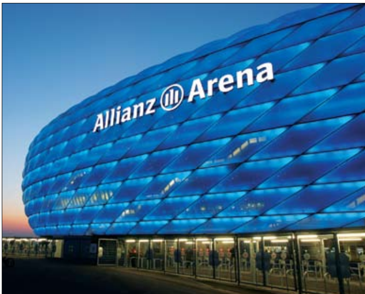
Nogometni stadion, arena Allianz, arhitekturnega biroja Herzog & de Meuron je zgrajen iz 2.874 zračnih panelov ETFE. Na stadionu se zaradi vzdrževanja kakovosti zelezine ne smejo prirejati koncerti in podobne prireditve. (Foto Allianz Arena/B. Ducke; detajl./Kaja Antlejš)
