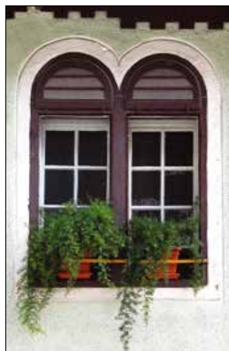
Detajl okna nad vhodom.
