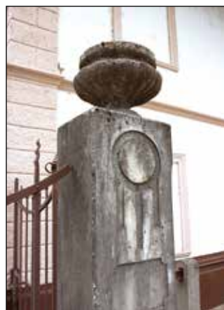
Betonski steber železne ograje ob hiši.
