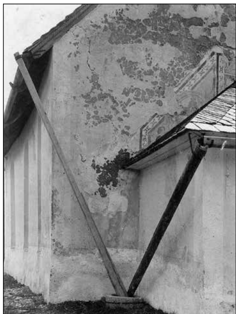
Predovjna fotografija sprednjega levega vogala cerkve. Na fotografiji se vidi, da je bila streha lope nižja in ni zaščitila fresk v celoti. Vidne so tudi lesene cevi za napeljavo deževnice in skril na strehi lope. Vir: Ministrstvo za kulturo, INDOK center.
