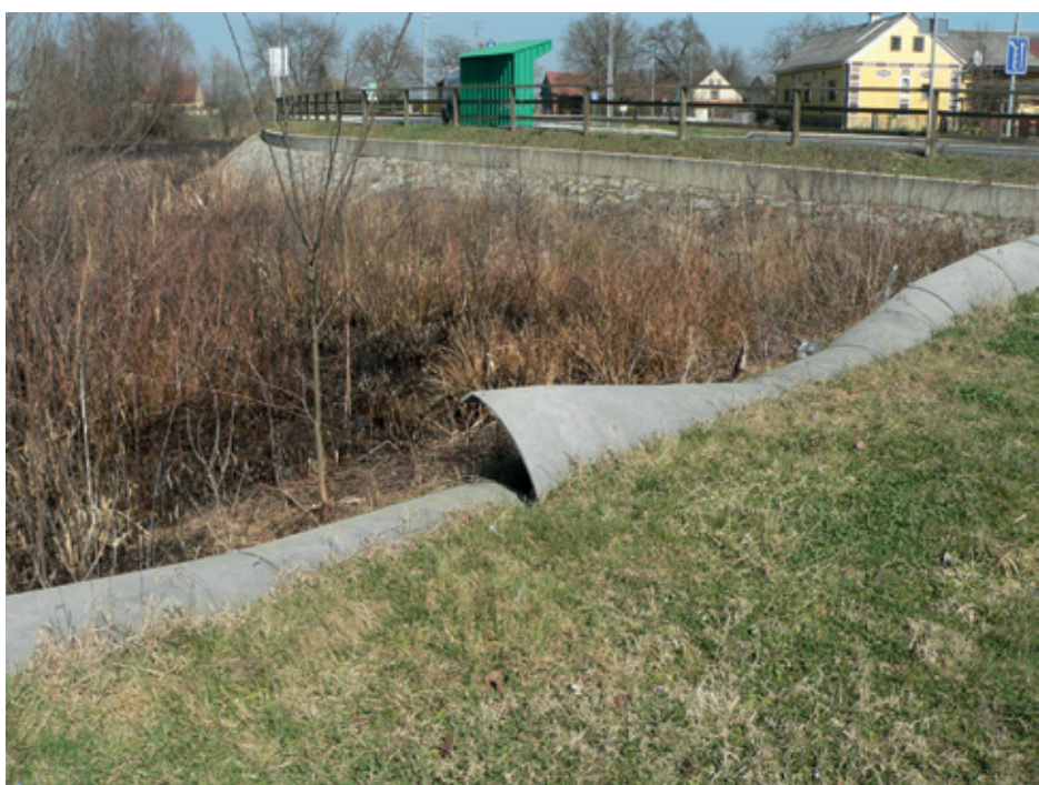
Cesta G1-3 Radenci–Petanjci. V letu 2002 so bile na odseku v naselju Petanjci na približni dolžini 500 metrov ob mrtvici Zaton postavljene plastične ograje ACO za dvoživke v kombinaciji z betonskim zidom (foto: Marijan Govedič, zgoraj, in Marta Jakopič, spodaj, obe 2006). Stanje ograje je v letu 2013 še slabše, saj je Direkcija za ceste še ni popravila.
